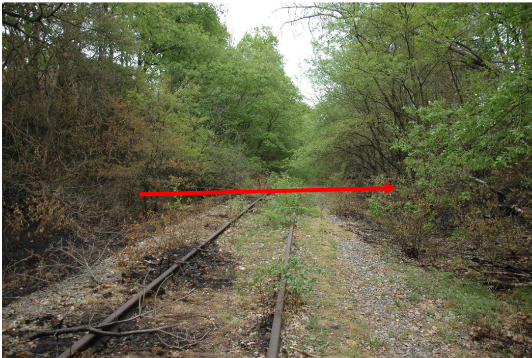
(Foto van spoorlijn waar brand overheen is geslagen. Foto 25)
